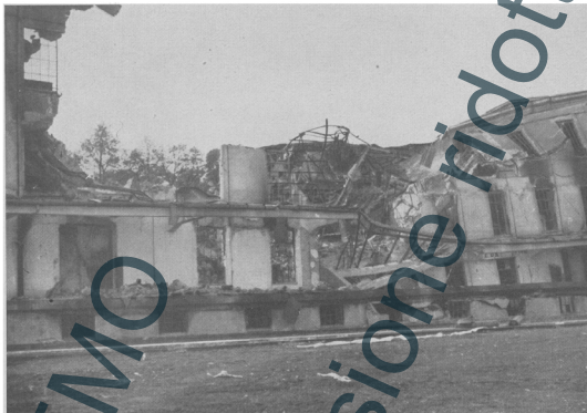
Wirkung einer SC 500 Güteklasse III m. V. gegen ein Betonlagerhaus.
