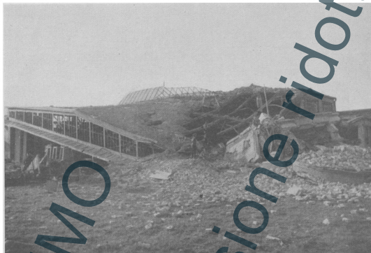
Wirkung einer SC 500 m. V. gegen eine moderne Flugzeughalle.
