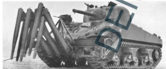
PANZERKAMPFWAGEN M 4 A 3 mit Minenräumgerät T 8
