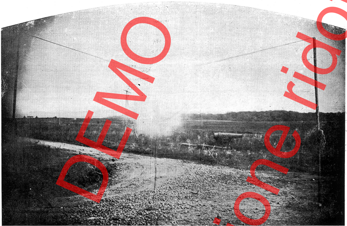
Scoppio in aria a riposo di detonatore di T. 4 in bossolo di alluminio \Phi 22.6 m/m innescato con cassulone forma allungata di gr. 2 di fulminato di mercurio in porta cassuloni di ottone.
