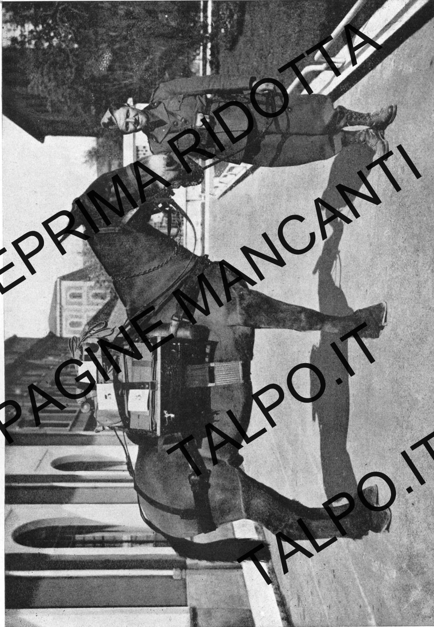
Disposizione del carico per il trasporto del pezzo su mulo Disposition de la charge pour le transport de la pièce à dos de mulet Disposición de la carga para el transporte del mortero a dorso de mulo
